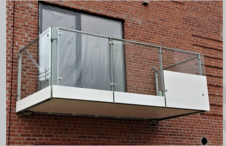
Glas monteret udvendigt
